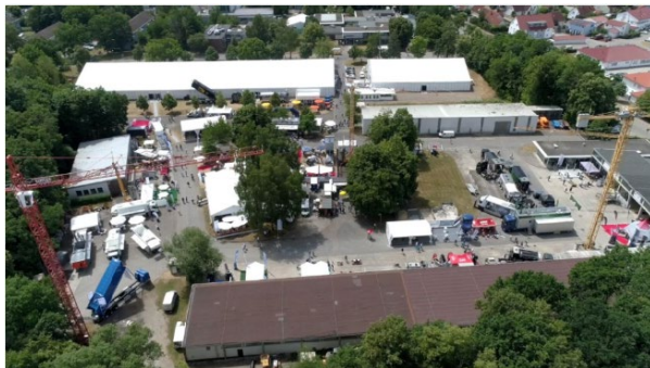
Bild 2: EPF2023 – Luftbild Messegelände © 2023 Bayerische BauAkademie
